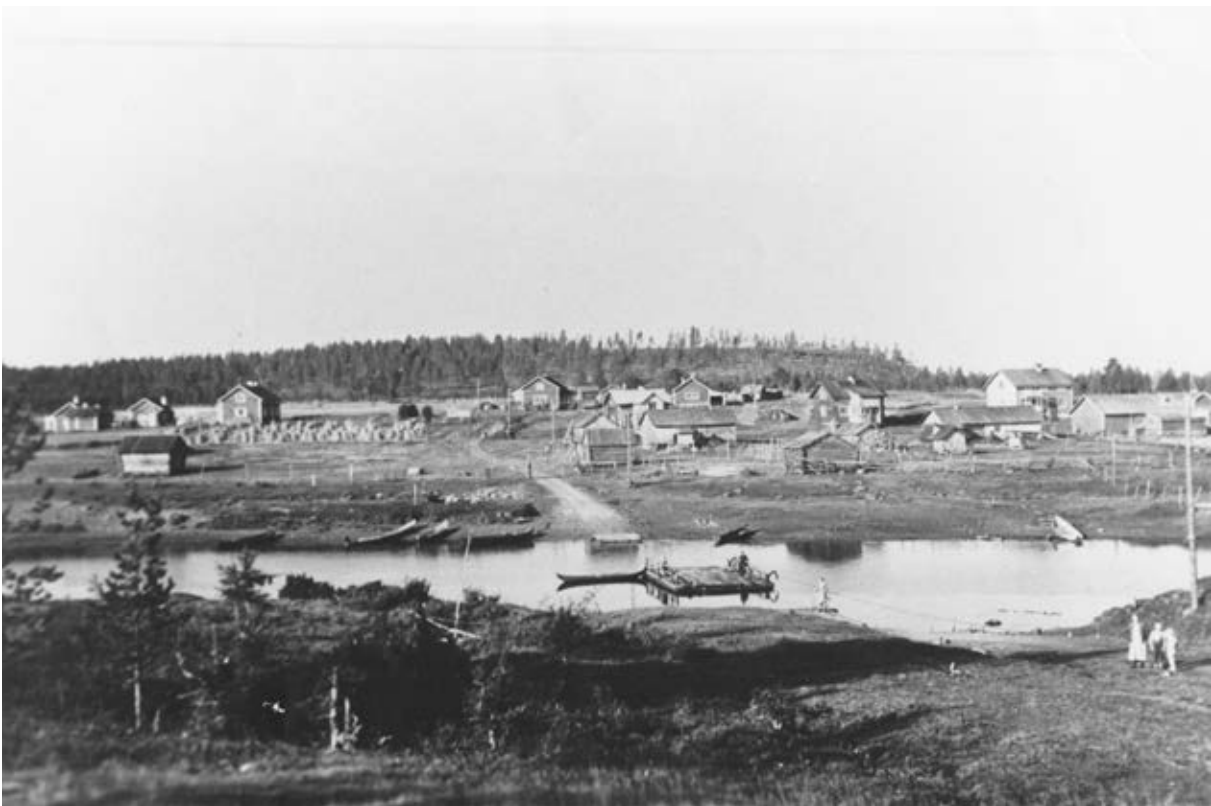
Lokan kylä ennen altaan rakentamista. Lähde Matti Kuivila.
