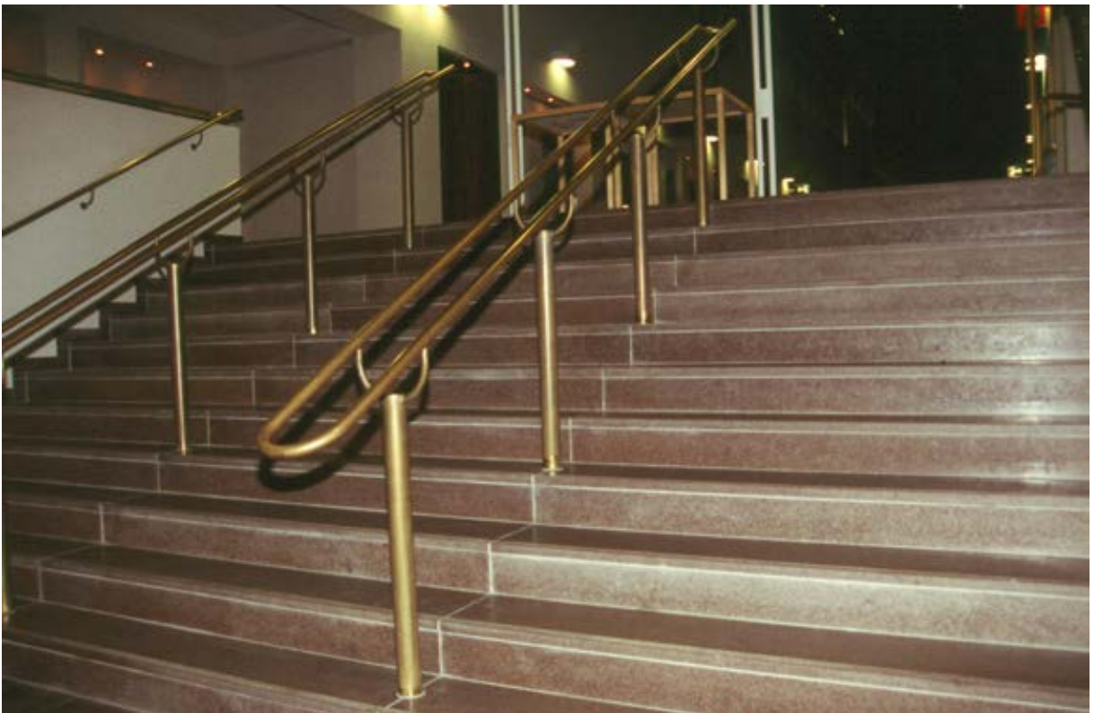
Kuva 42. Meltauksen punaruskeaa graniittia Rovaniemen Arktikumissa. Kuva R. Vartiainen. Fig. 42. Reddish brown granite from Meltaus, used in Arktikum Museum and Arctic Science Centre, Rovaniemi. Photo R.Vartiainen.
