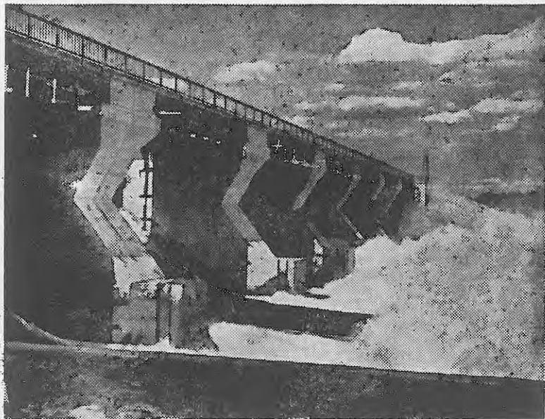
Petäjäskosken voimalaitoksen säännöstelypato
