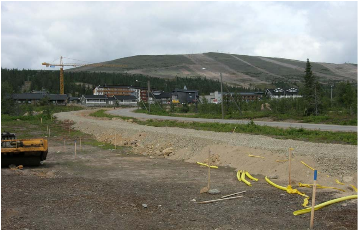
Kuva 3. Jatkuvasta rakentamisesta ja liikenteestä johtuen aktiiviset matkailukeskukset ovat meluisia ja synnyttävät ristiriitaa perinteisesti hiljaisena pidetyssä luontomatkailuäänimaisemassa. Kuva Pertti Sarala.
