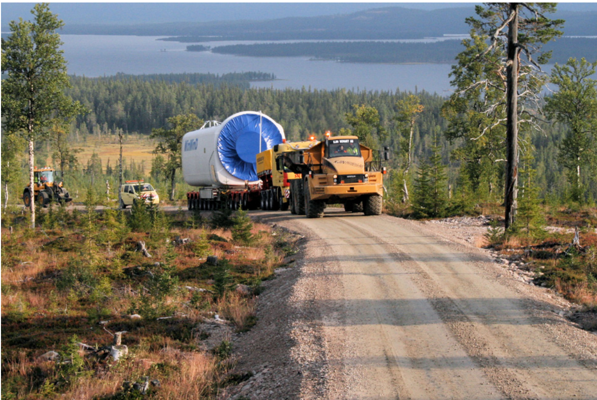
Kuva 3. Suomalaisvalmisteisen 3 MW tuulivoimalan konehuone matkalla kohti pystytyspaikkaa Uljabuodan tuulipuistossa Pohjois-Ruotsissa. Kuva: WinWind.
