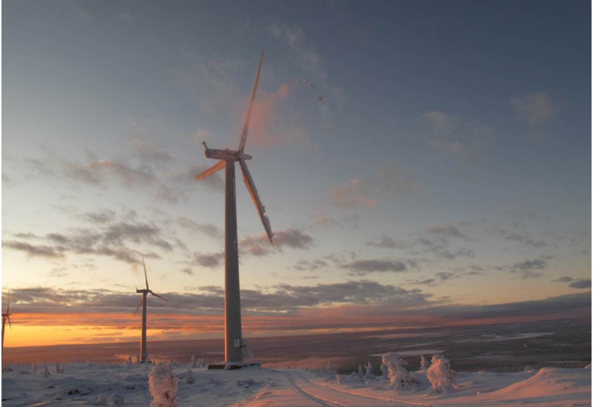
Kuva 2. Esimerkki jään kertymisestä tuulivoimalan lapoihin Olostunturin tuulipuistossa jäänestöjärjestelmän ollessa poissa toiminnasta. Kuva: VTT.
