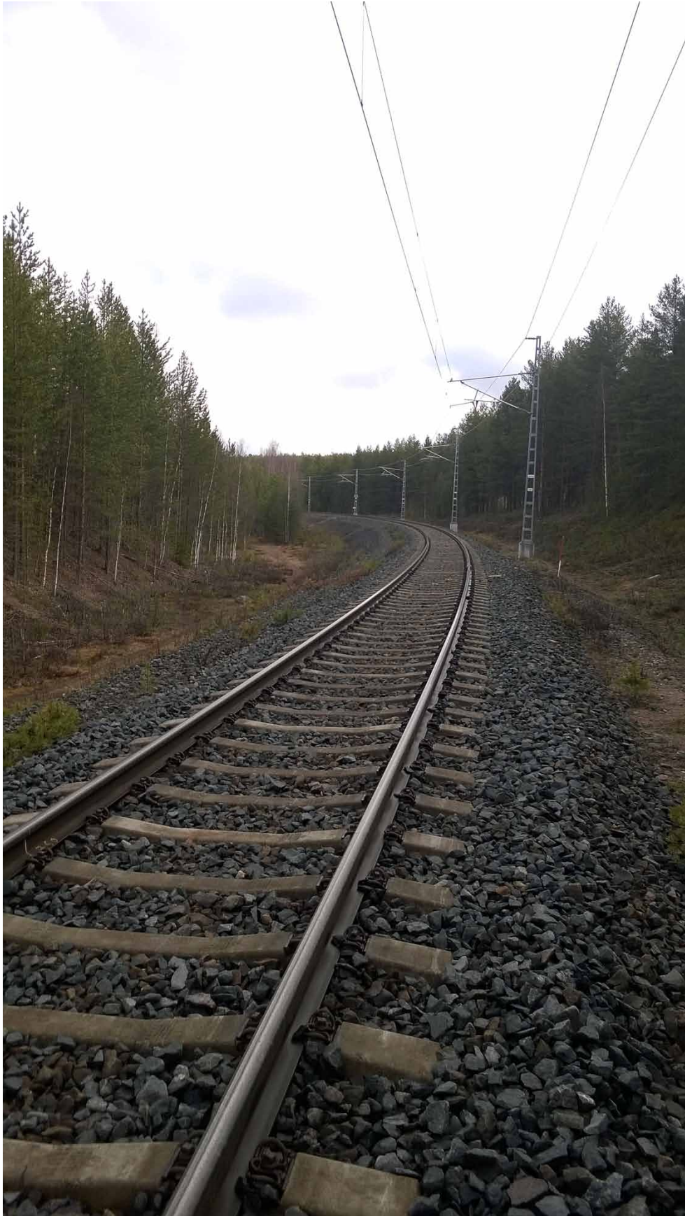
Moderni, sähköistetty junarata Rovaniemeltä Kemijärvelle. Kuva P. Sarala
